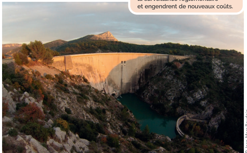
Barrage du Lac de Bimont.
